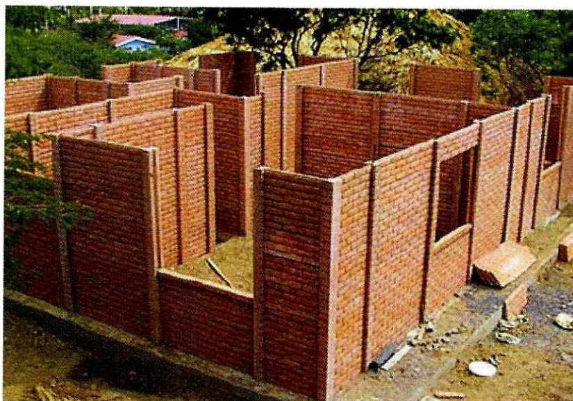
Foto No.15 Diseño de ladrillo
