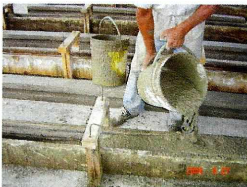
Foto No. 10 Columnas livianas
