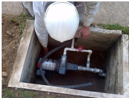
Imagen 18: Arreglo e Instalación de bomba centrífuga 0.5 hp starite.
