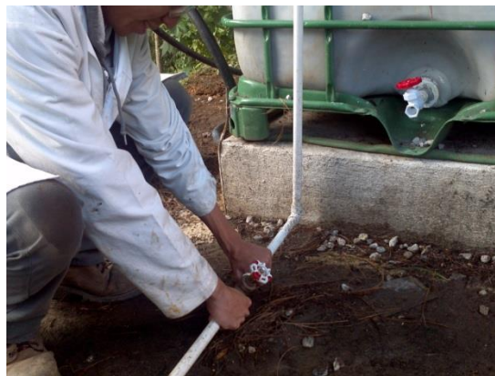
Imagen16: Instalación de tubería de PVC ½ "
