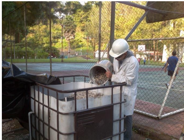
Imagen 22: Llenado de humedales con piedra de diferente gravimetría por cubeteo.
