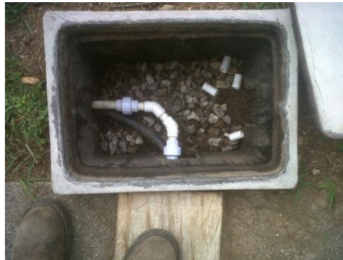
Imagen 15: Arreglo de tubería de PVC de ½ "en cajas de registro
