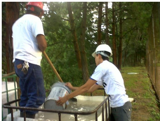
Imagen 24: Limpieza de piedrín dentro de un humedal.
