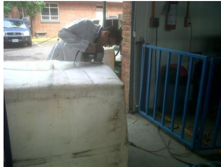
Imagen 13: Ajustes de tanque cúbico para humedal de flujo subsuperficial.
