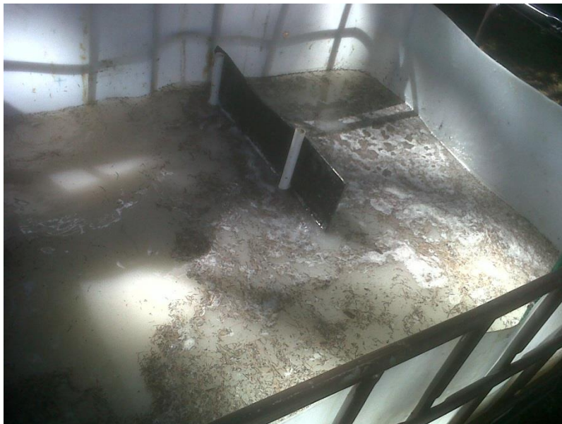
Imagen 24: Limpieza de piedrín dentro de un humedal.
