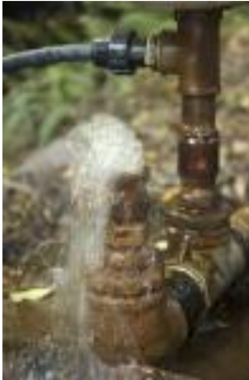
Figura 19: Imagen de bomba de ariete.
