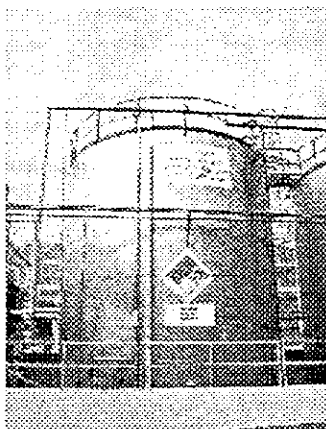
Figura 1: Fotografía del tanque tanque de sebo
