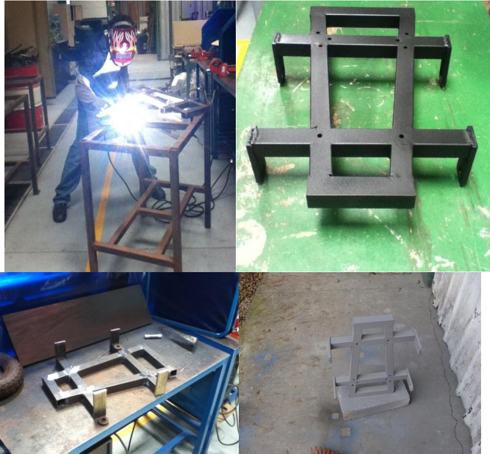
Figura 47. Construcción de estructura
