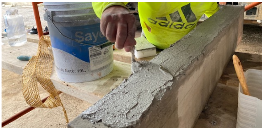
Figura 25: Primera capa de mortero (Fuente: Elaboración propia)
