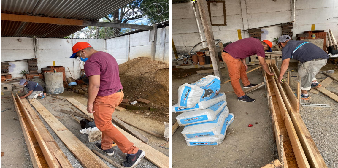
Figura 57: Anexo 6 – “Armado de formaleta” (Fuente: Elaboración propia)
