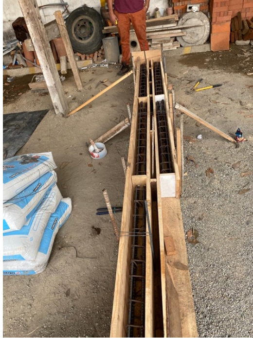
Figura 20: Colocación de la armadura en la formaleta (Fuente: Elaboración propia)
