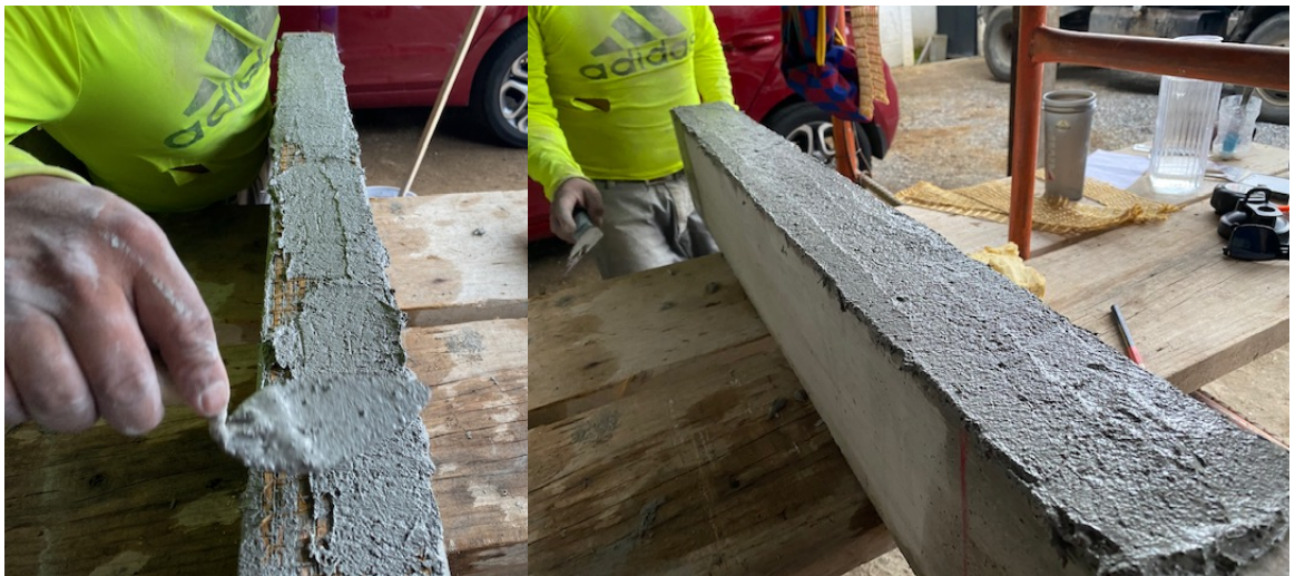
Figura 27: Colocación de la última capa del mortero (Fuente: Elaboración propia)
