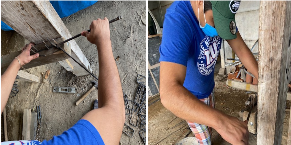
Figura 54: Anexo 3 – “Elaboración de estribos” (Fuente: Elaboración propia)
