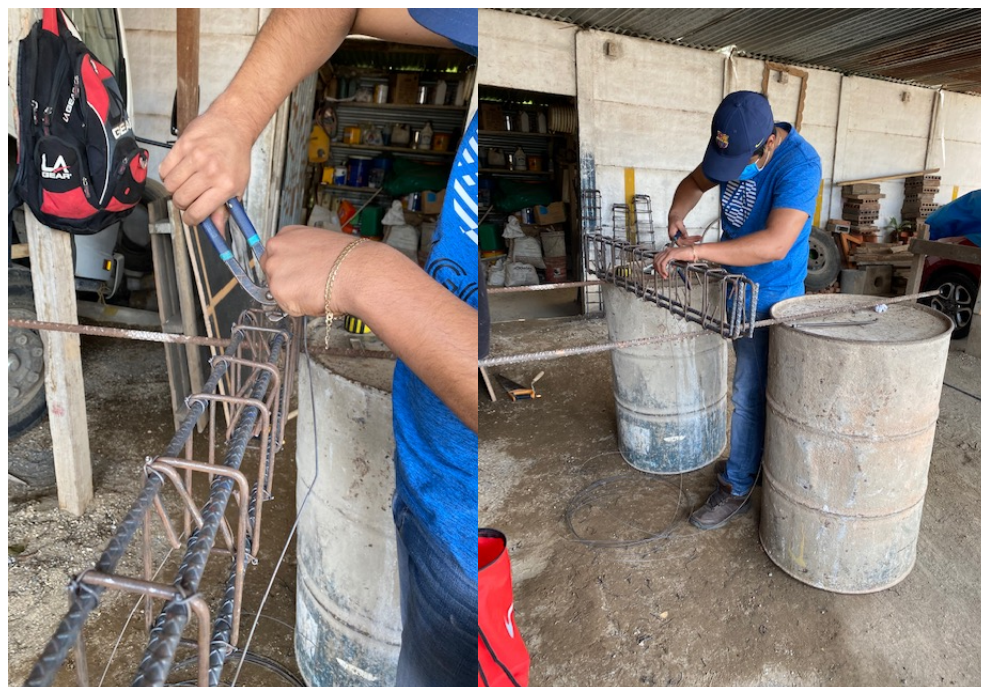
Figura 56: Anexo 5 – “Armado de vigas” (Fuente: Elaboración propia)
