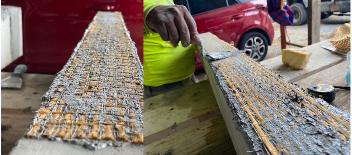
Figura 26: Colocación de la malla (Fuente: Elaboración propia)
