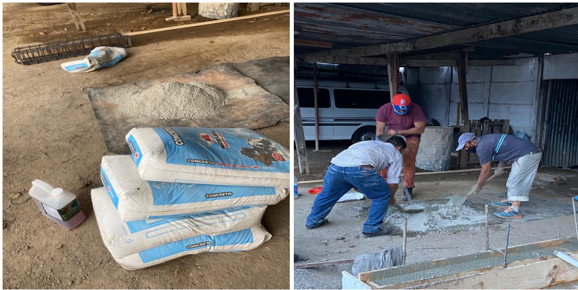
Figura 58: Anexo 7 – “Mezcla del concreto” (Fuente: Elaboración propia)
