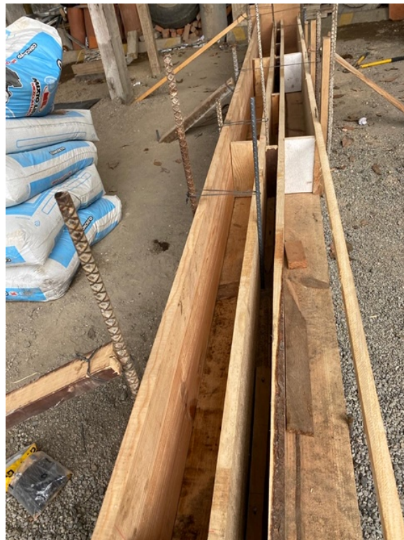
Figura 19: Formaleta de las vigas (Fuente: Elaboración propia)
