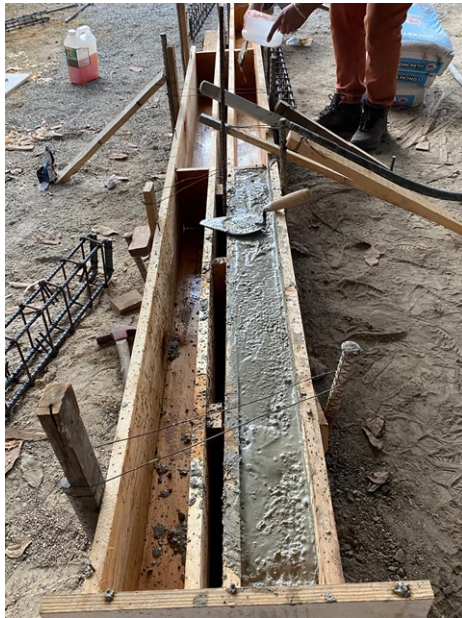
Figura 60: Anexo 9 – “Fundición de vigas” (Fuente: Elaboración propia)
