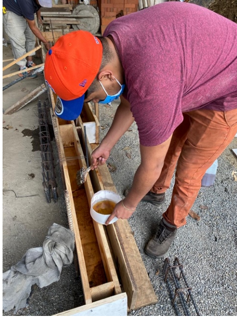
Figura 59: Anexo 8 – “Aplicación del desencofrado en la formaleta” (Fuente: Elaboración propia)
