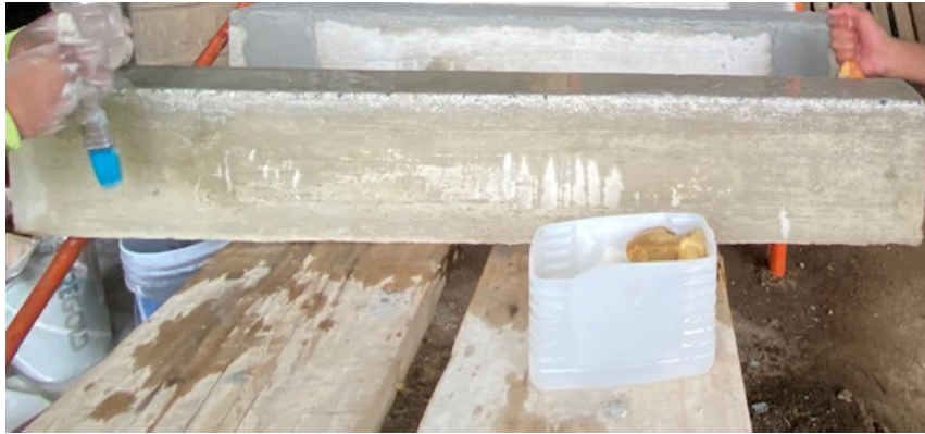
Figura 24: Humedecido de la superficie a reforzar (Fuente: Elaboración propia)
