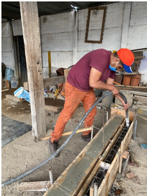
Figura 62: Anexo 11 – “Vibrado del concreto” (Fuente: Elaboración propia)
