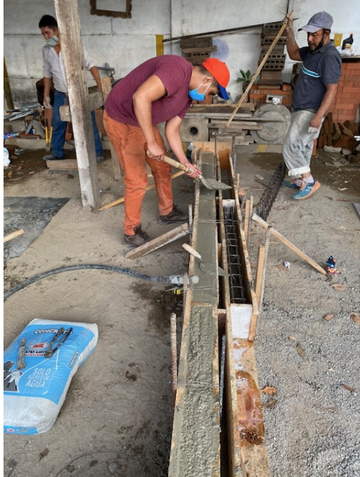
Figura 61: Anexo 10 – “Fundición de vigas 2” (Fuente: Elaboración propia)
