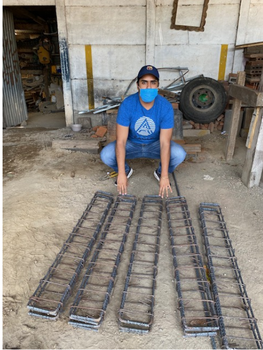
Figura 18: Armadura de las vigas (Fuente: Elaboración propia)
