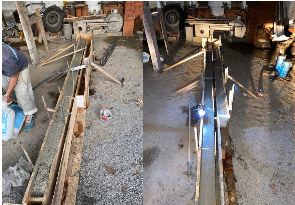
Figura 21: Fundición de vigas (Fuente: Elaboración propia)
