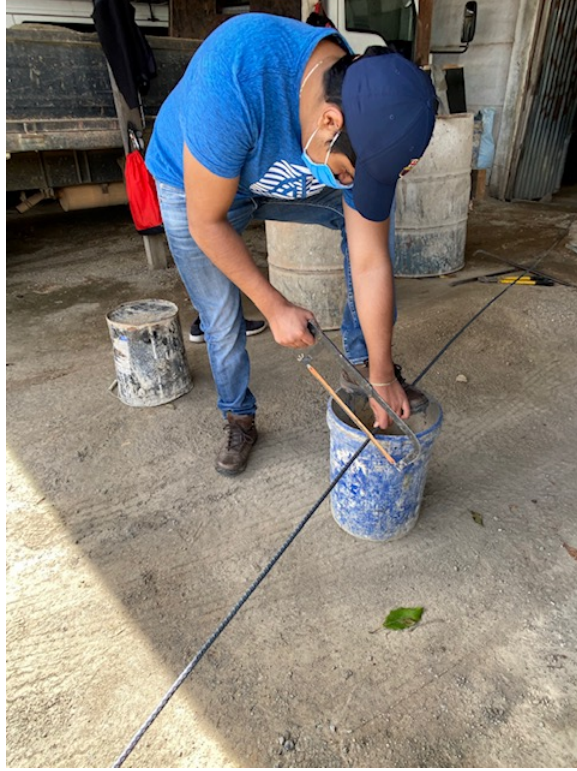
Figura 53: Anexo 2 – “Corte de varillas” (Fuente: Elaboración propia)
