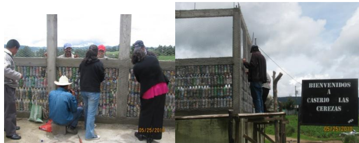
Ilustración 10: Escuela el Caserío Las Cerezas, Quetzaltenango.
