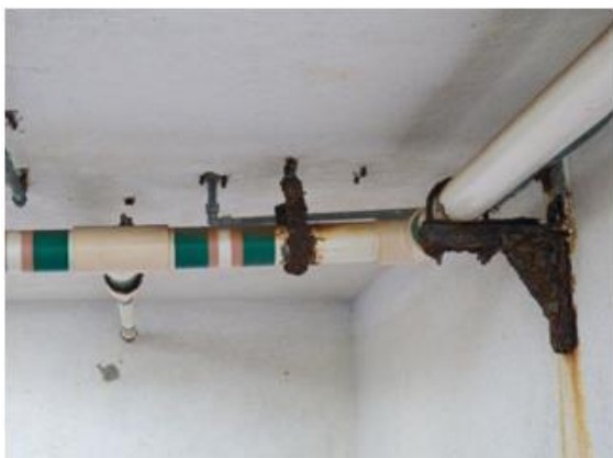
Figura No. 98. Bridas de retención corroídas.
