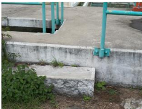
Figura No. 101. Corrosión de barandas.
