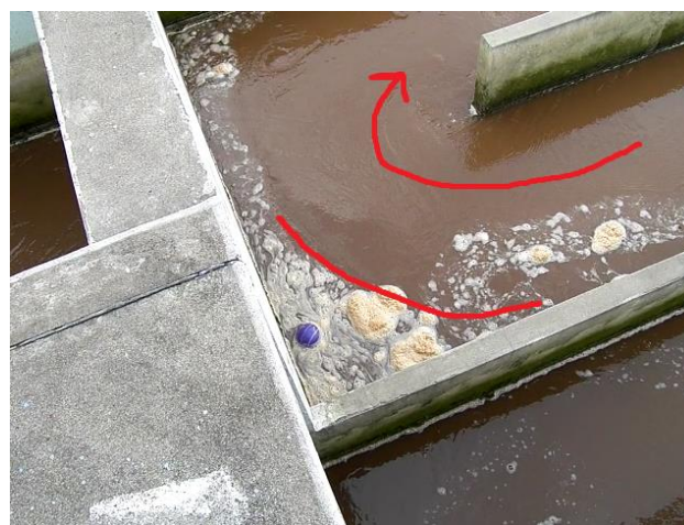
Figura No. 118. Esquinas de floculación afectados.
