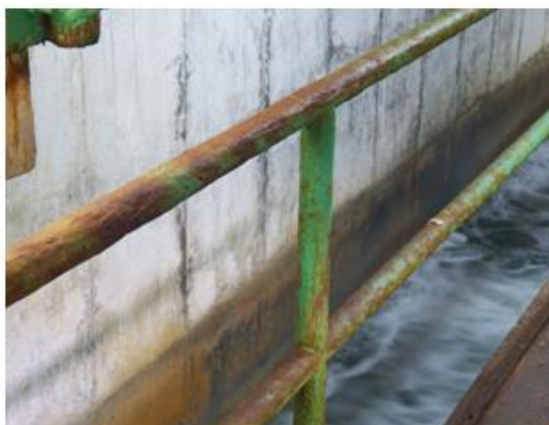
Figura No. 101. Corrosión de barandas.
