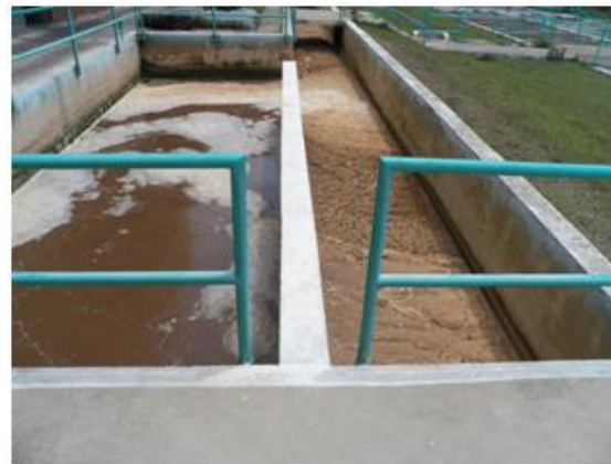
Figura No. 107. Falta de completión de baranda.
