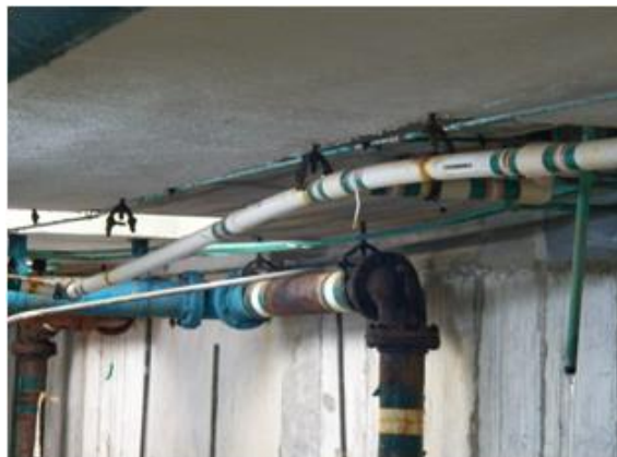
Figura No. 112. Tubería en mal estado.
