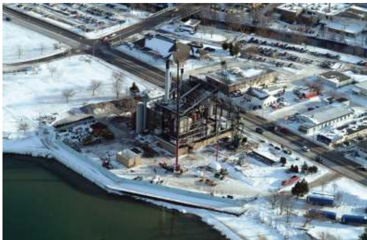
Ilustración 5.2: Fase de desmontaje de la planta
