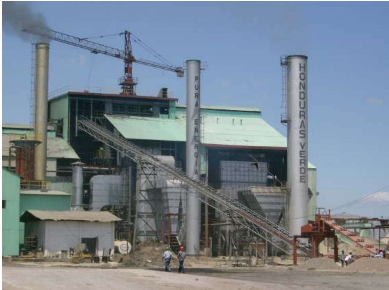
Ilustración 9.9: Vista exterior de la caldera (Chimenea de en medio; Pura Energía) instalada en el Ingenio La Grecia, Choluteca, Honduras
