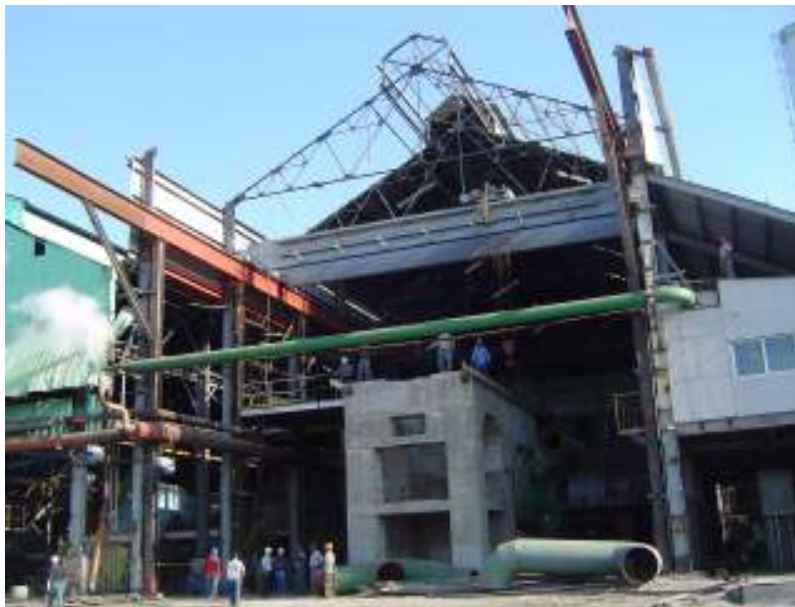
Ilustración 5.7: Obra civil para la instalación del turbogenerador
