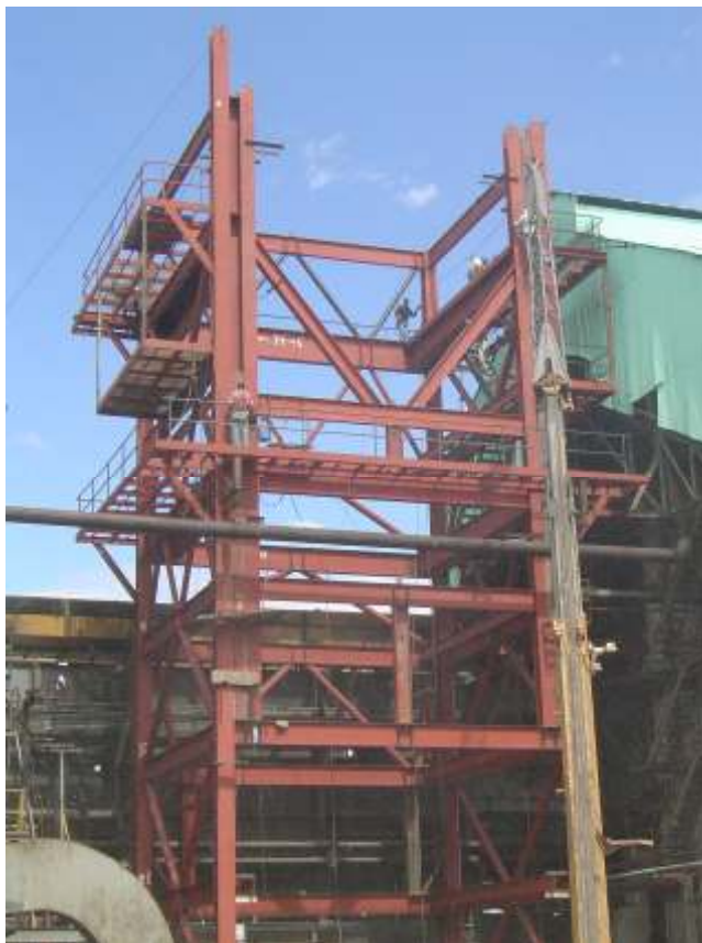
Ilustración 5.4: Instalación de la estructura principal de la caldera
