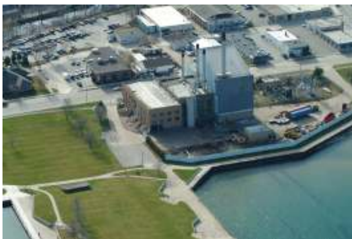
Ilustración 5.1: Planta térmica instalada en Traverse City, Michigan, Estados Unidos
