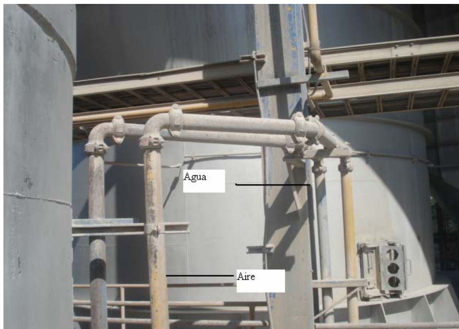
Figura 20. Ilustración de entrada de Tubería al Downcomer
