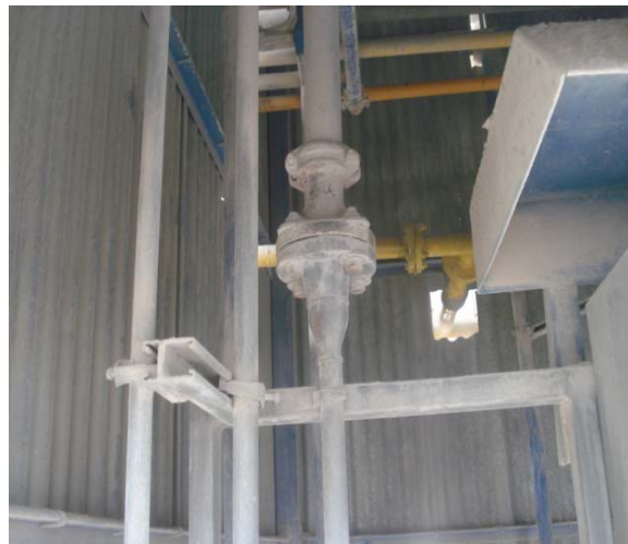
Figura 18. Salida de tubería del rack
