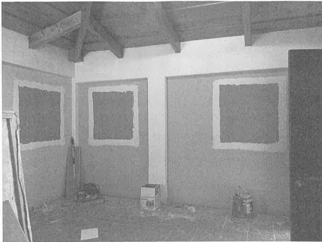
Figura 3. Desarrollo de trabajos de tablayeso para cubrir ventanas.
