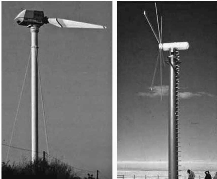
Figura 37: Turbinas de generación con dispositivos de sustentación
