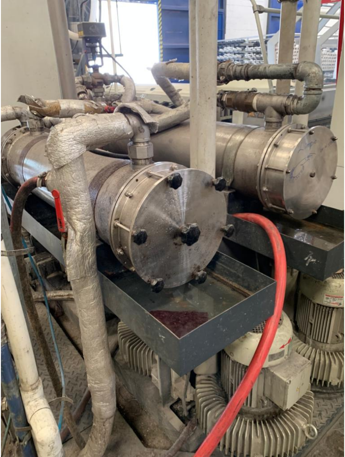
Figura 18. Intercambiador de calor carcasa y tubos.
