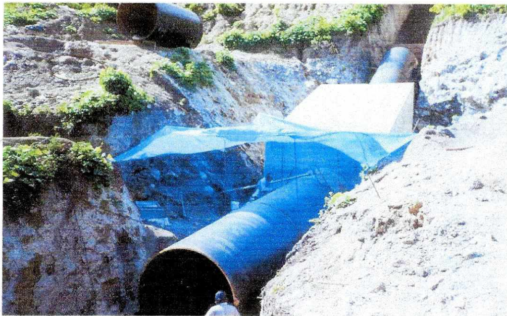
Imagen No. 5: Codo con anclaje ubicado en la est. 519.
