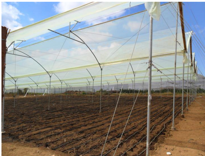
Ilustración 23: Sistema de riego por goteo en invernadero vecino
