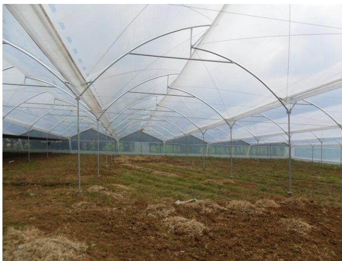
Ilustración 25: Techo de un invernadero
