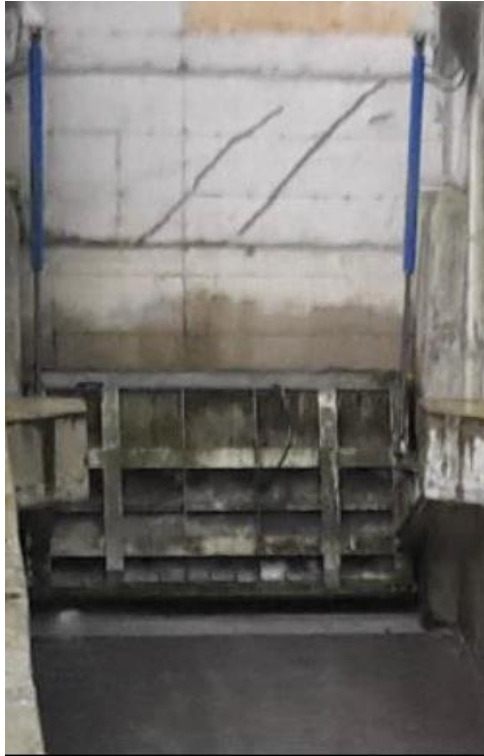
Figura 41. Regulación de nivel, apertura de compuerta radial al 40%.
