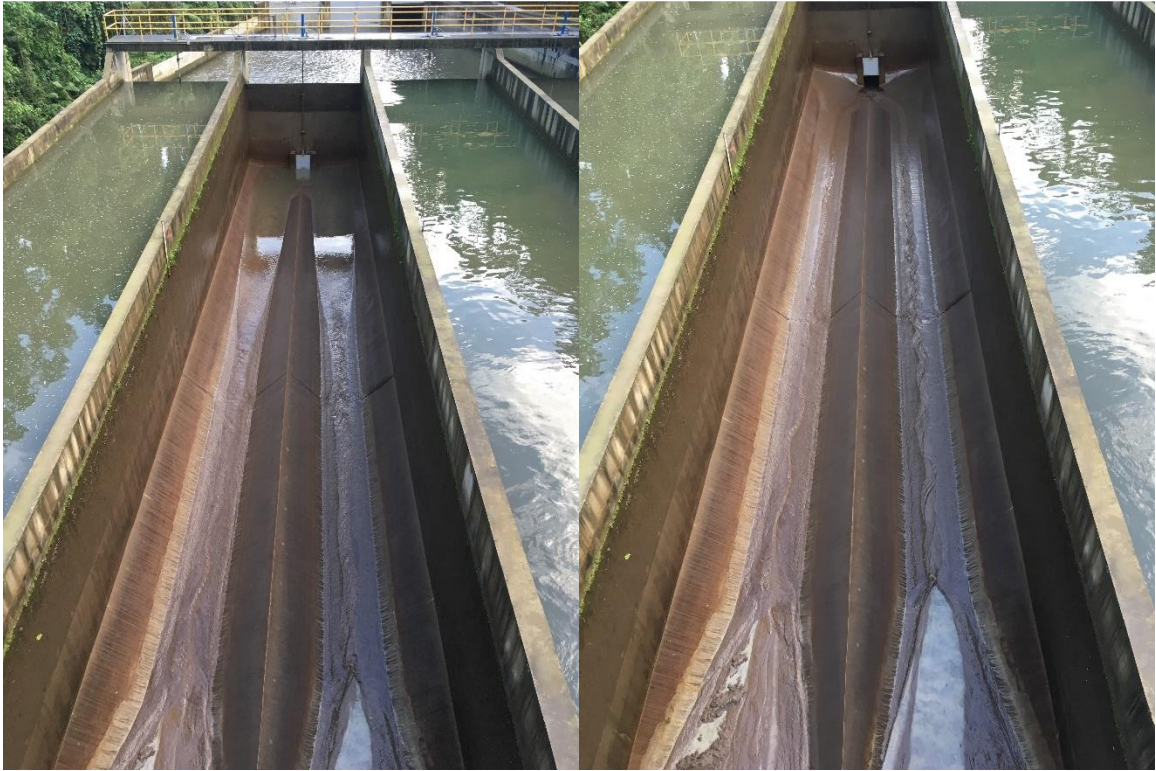
Figura 37. Limpieza de canal, vistas de canal vacío con sedimentos sólidos en el fondo.
