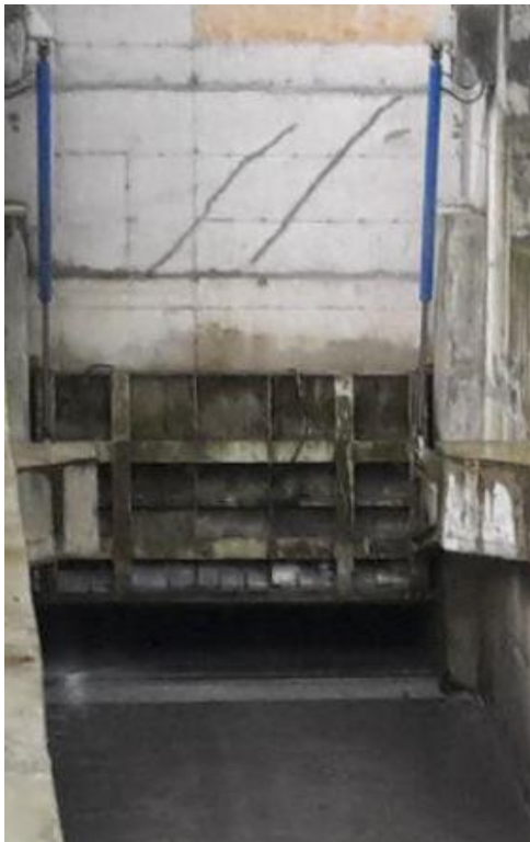
Figura 41. Regulación de nivel, apertura de compuerta radial al 40%.
