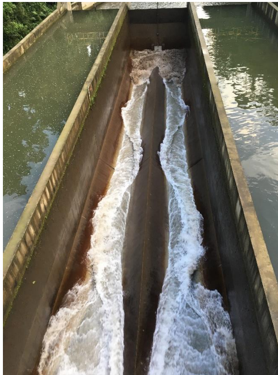
Figura 38. Limpieza de canal, apertura de la compuerta de entrada al 1% para ingreso de agua a presión.
