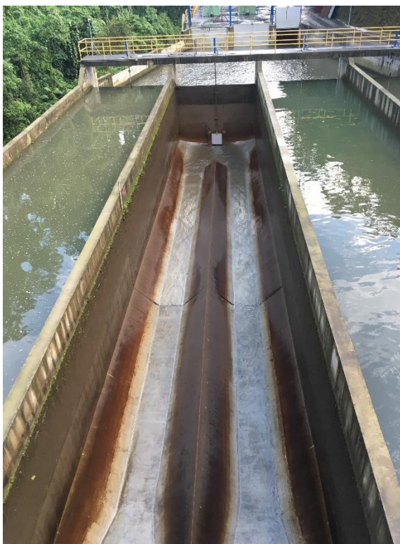
Figura 39. Limpieza de canal, limpio y cerrando compuerta de fondo para rellenado de agua en canal.
