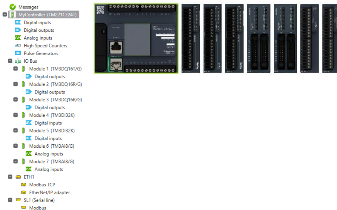
Figura 13. PLC Schneider Electric TM221CE24T, más módulos de expansión.
