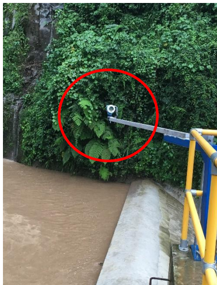
Figura 17. Sensor de nivel ultrasónico Endress+Hauser FMU41. Ejemplo de ubicación en campo.
