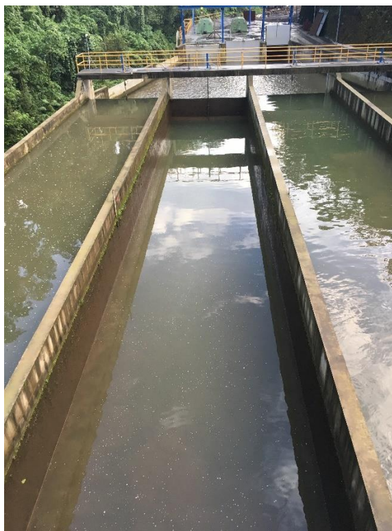
Figura 36. Limpieza de canal, vaciado de canal luego de cierre de compuerta de entrada y apertura de compuerta de fondo.
