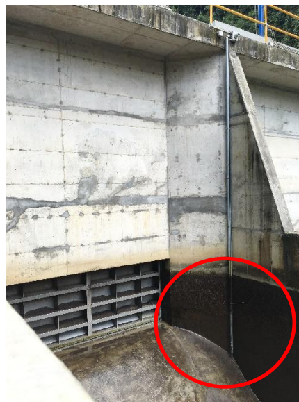
Figura 16. Sensor de nivel sumergible AST4510. Ejemplo de ubicación en campo.
