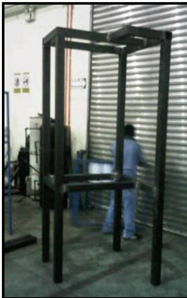
Figura 16. Proceso de soldado de estructura
