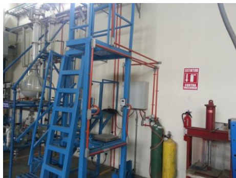
Figura 22. Parte inferior de la estructura
