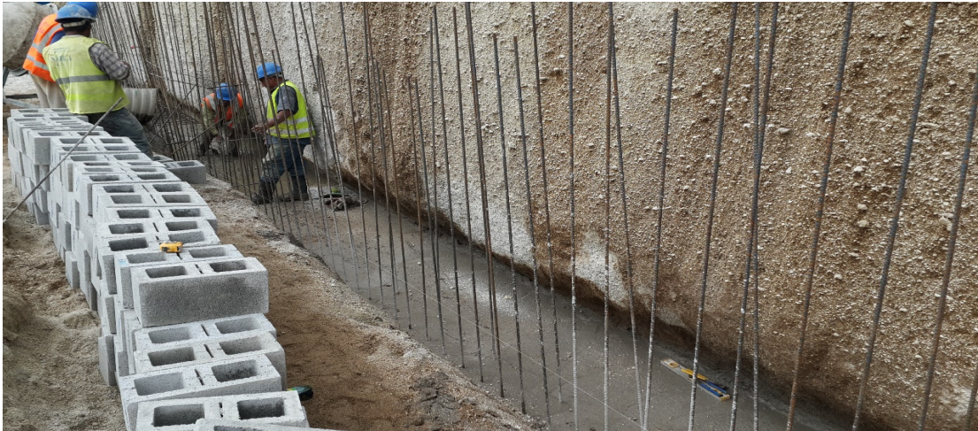
Imagen No. 2. Colocación de blocks.
