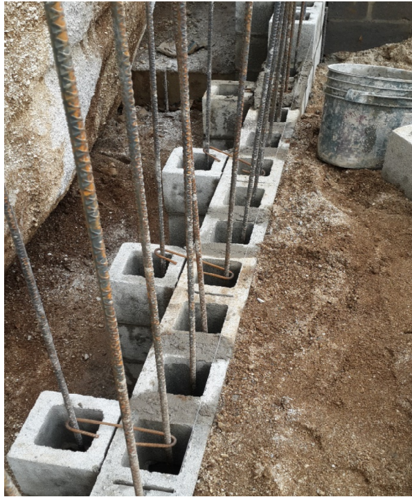
Imagen No. 3. Refuerzos de corte.
