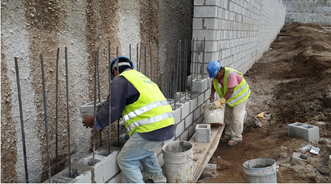
Imagen No. 5. Levantado del muro
