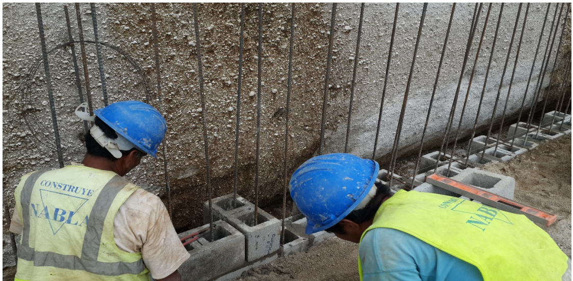
Imagen No. 2. Colocación de blocks.
