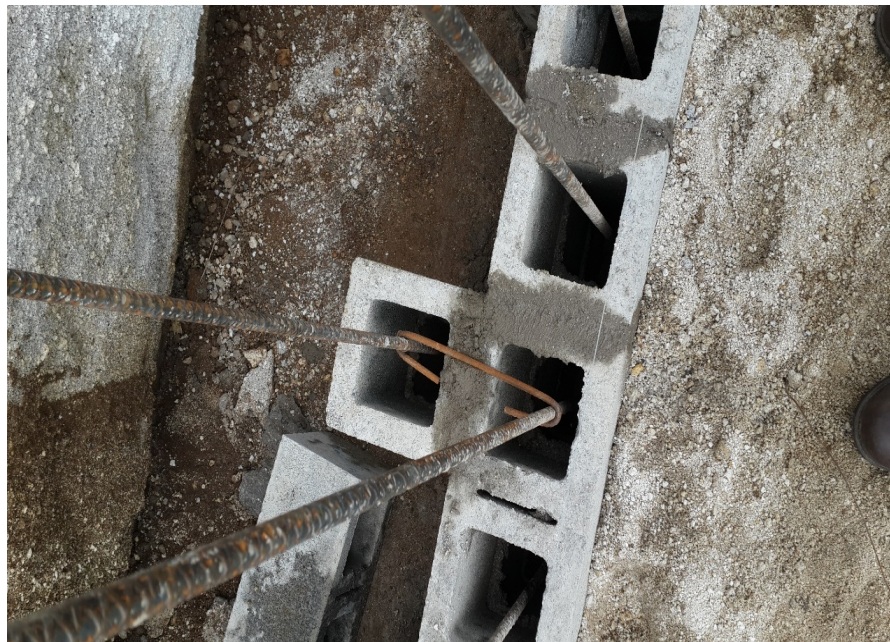
Imagen No. 4. Colocación de refuerzo para corte.
