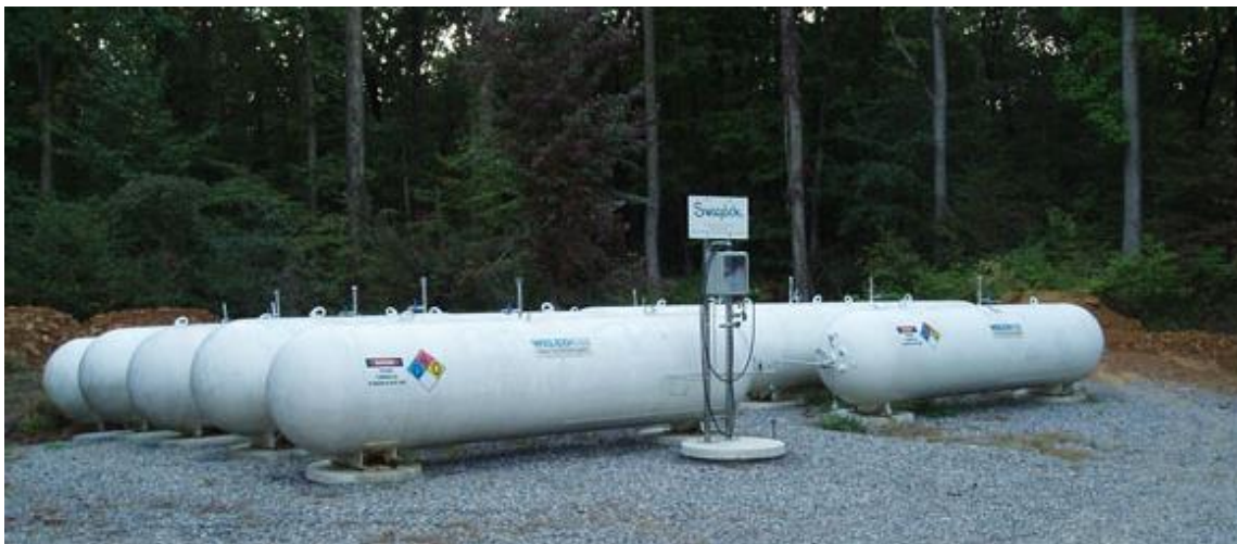
FIGURA 37: Tanques de hidrógeno de baja presión utilizados en la casa de hidrógeno solar del científico Mike Strizki
