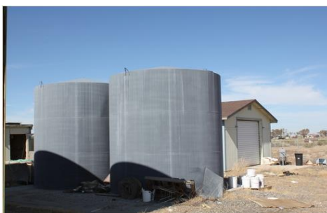
FIGURA 18: Contenedor de aguas residuales
