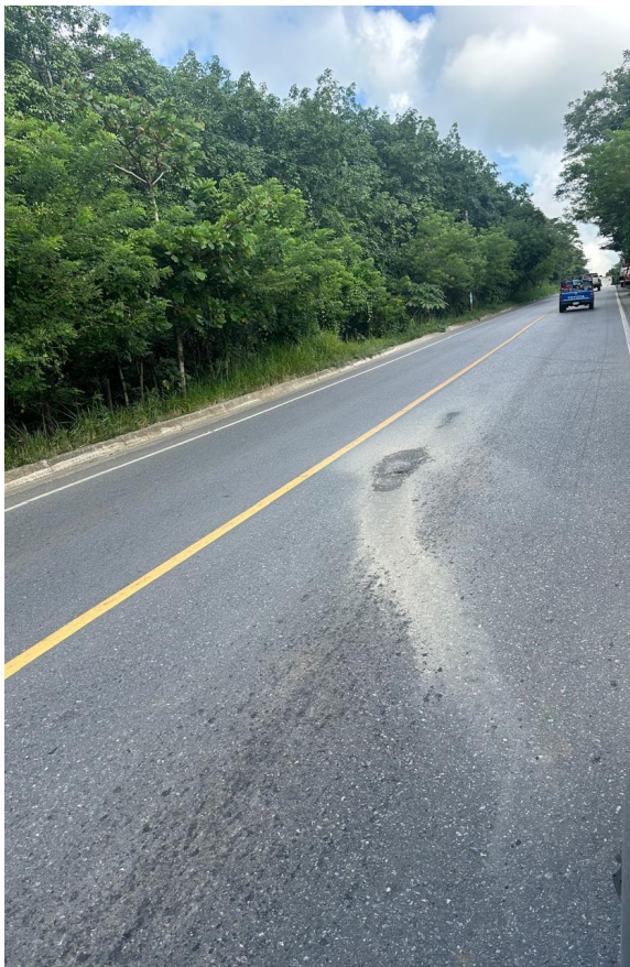
Figura 42. Ahullamiento transversal km.254
