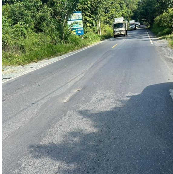
Figura 38. Bache y huella de rodadura km.247
