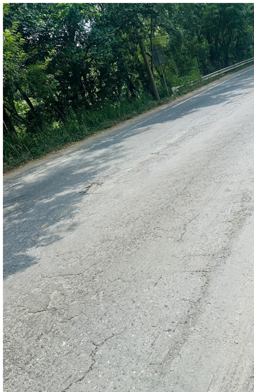
Figura 34. Pérdida de agregado km.205 (área de curva)
