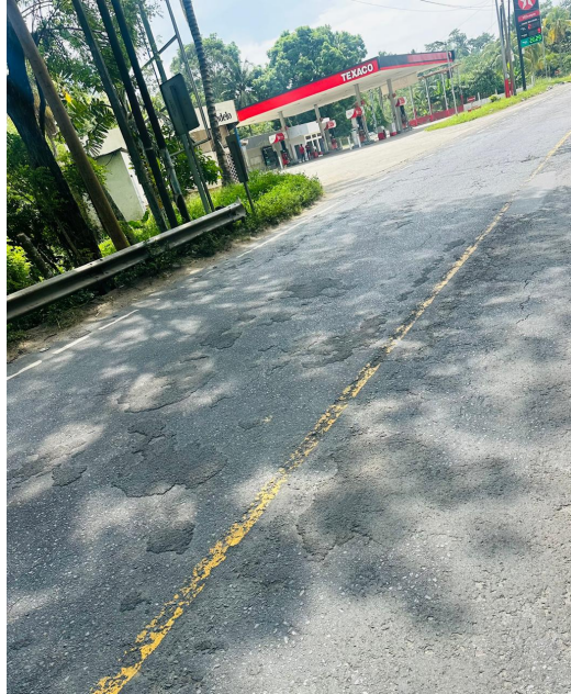
Figura 34. Pérdida de agregado km.205 (área de curva)
