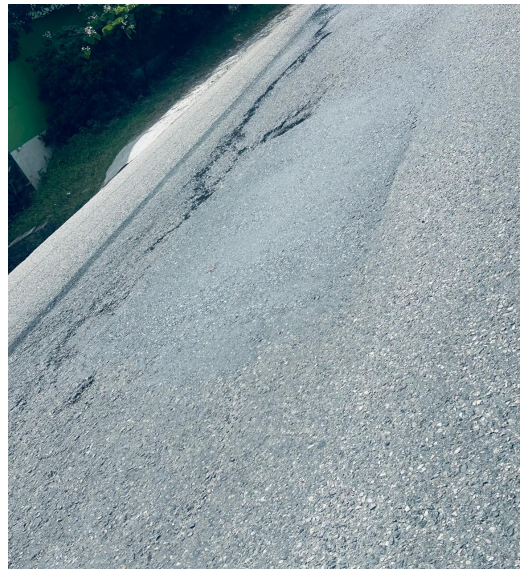
Figura 32. Ahullamiento longitudinal (huella de rodadura) km.200
