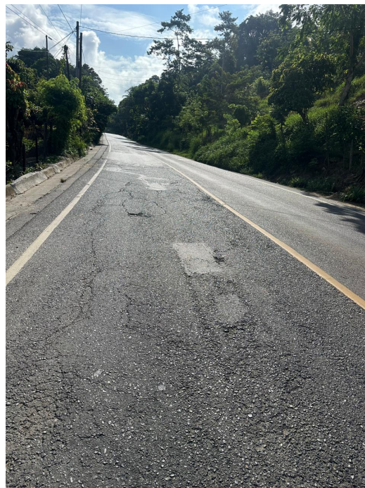
Figura 38. Bache y huella de rodadura km.247
