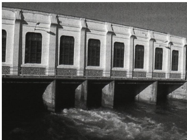
Figura No.19 Ataguías de la presa de Ardisa
