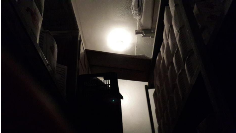
Fotografía 18 Paso para transitar en los racks superiores adentro de cuarto frío de almacenamiento
