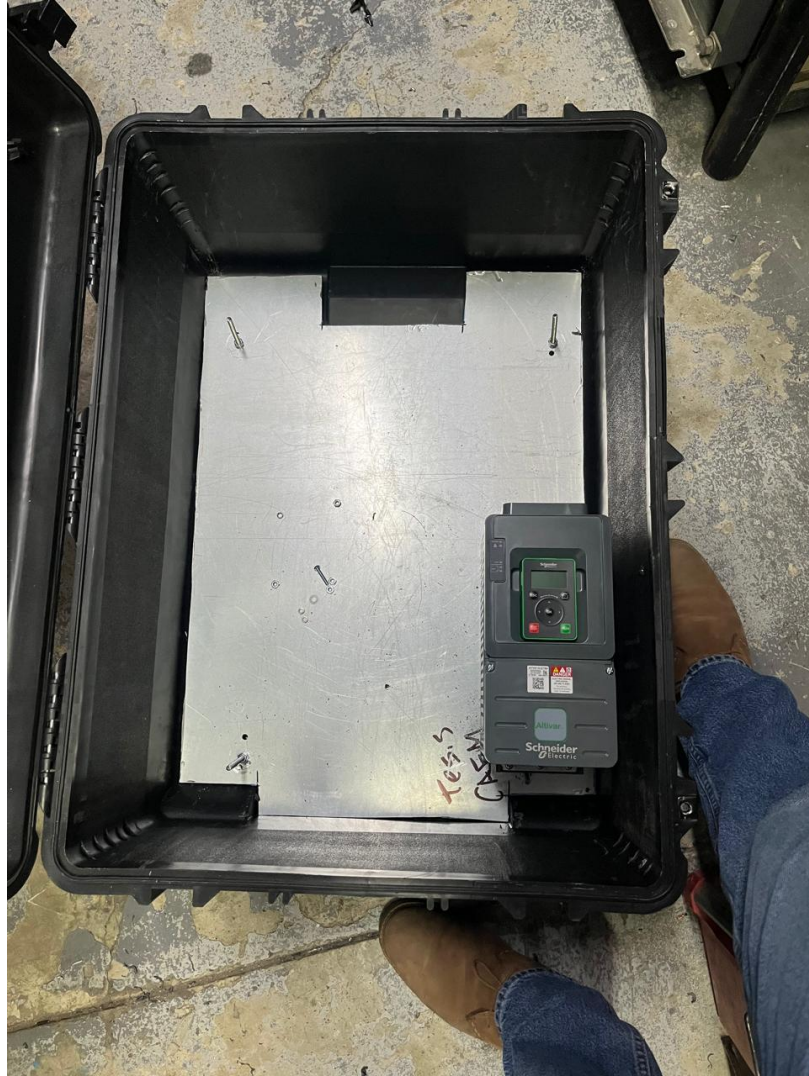
Figura 52. Variador de frecuencia instalado en la placa
