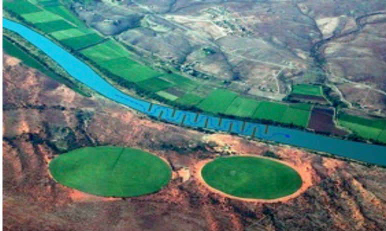
Ilustración 14: Diques transversales dentro del cauce del río
