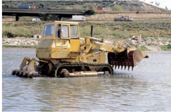
Ilustración 15: Escarificación del fondo del río
