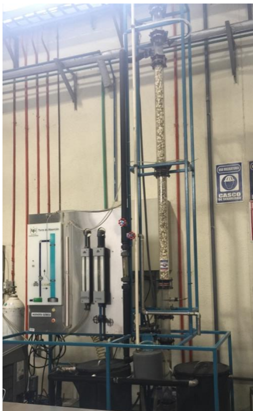
Figura 24. Estado actual de la torre de absorción.
