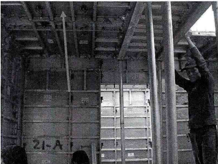
Ilustración No. 38 Formaleta de la losa "Encinos 6 de Cayalá"
