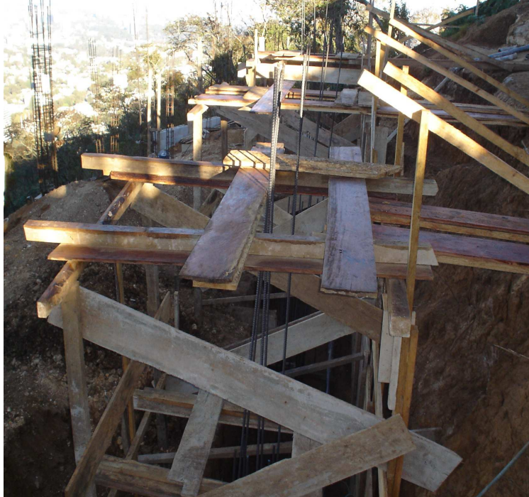
Figura VIII-18 obra falsa de madera para realizar la fundición.
