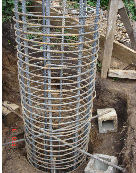
Figura VIII-11 Detalle de armado de pilote.
