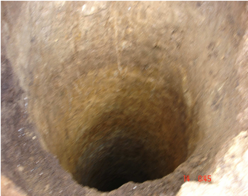
Figura VIII-13 Excavación artesanal y limpieza de pilote.
