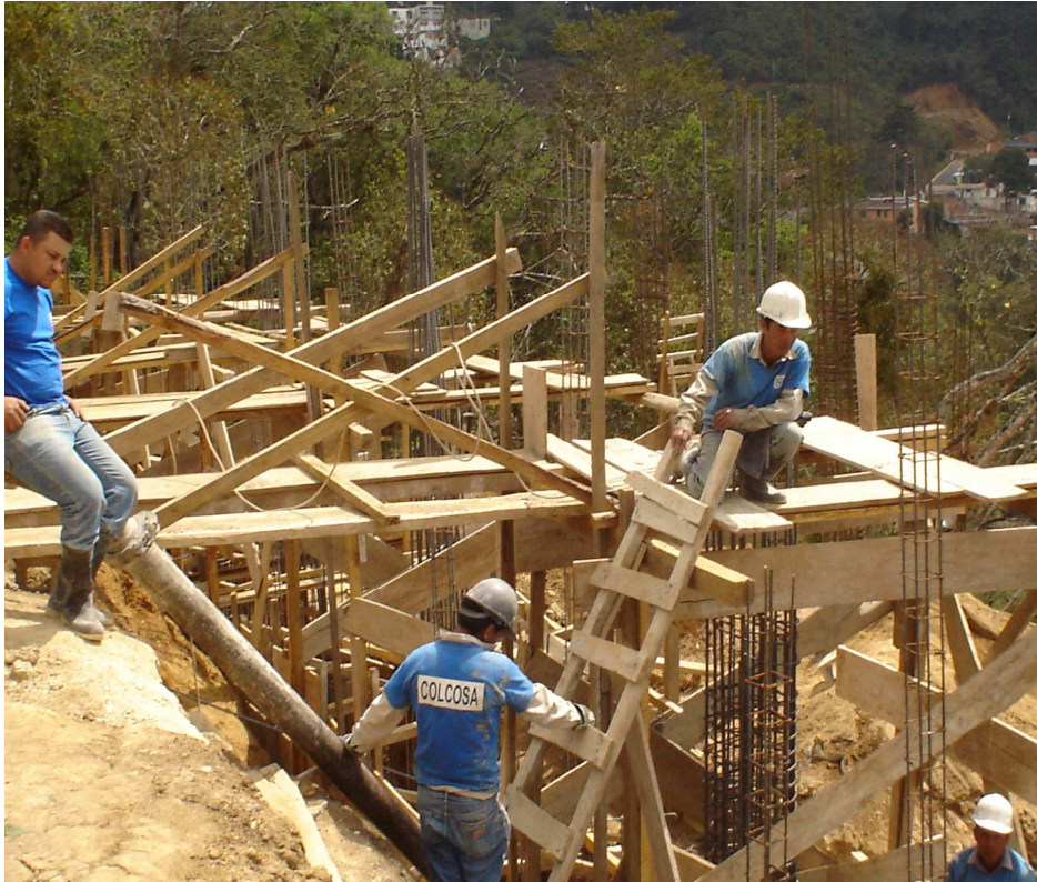
Figura VIII-16 Fundición de pilotes utilizando trompa de elefante.
