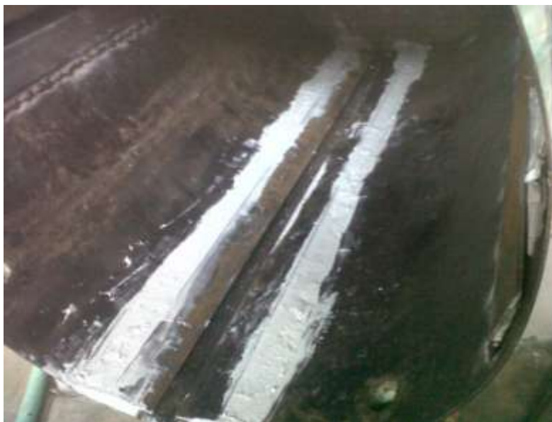
Figura No. 21 Enmasillado de rieles.
