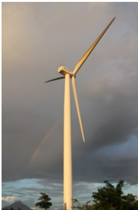
Imagen 9. Aerogenerador de eje horizontal de AMAYO de 2.1 MW (14)
