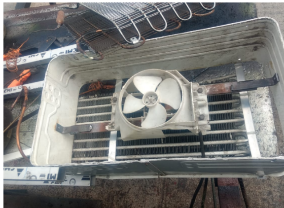
Figura 41: Colocación del ventilador
