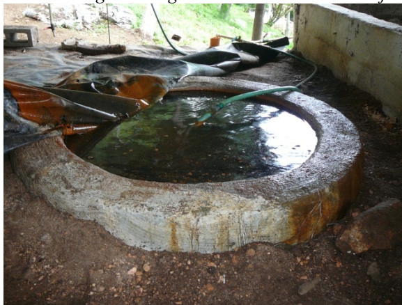
Figura 31: Tanque de descarga (efluente) del digester anaerobio de la Granja Agua Blanca.
