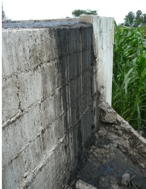
Figura 24: Rebalse del efluente del digestor anaerobio de la Granja La Flor.
