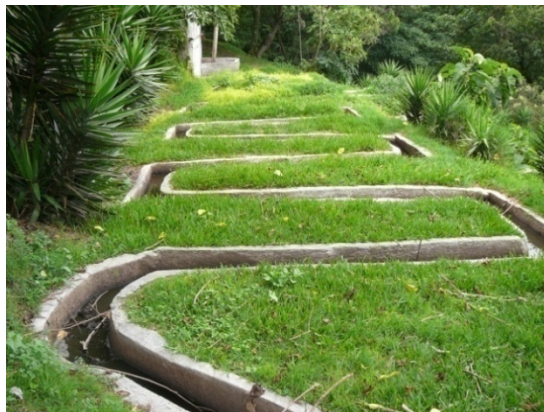
Figura 34: Conducción desde la segunda pileta de estabilización hacia campos aledaños a la Granja Agua Blanca.
