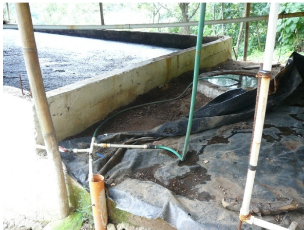
Figura 35: Distribución del biogás del digestor anaerobio de la Granja Agua Blanca hacia dos granjas de consumo.
