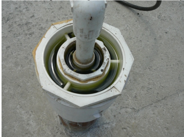
Figura 22: Salida de biogás en el digestor anaerobio de la Granja La Flor.
