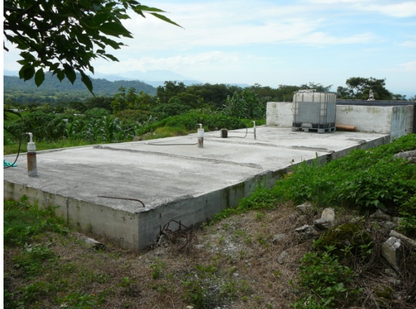
Figura 22: Salida de biogás en el digestor anaerobio de la Granja La Flor.
