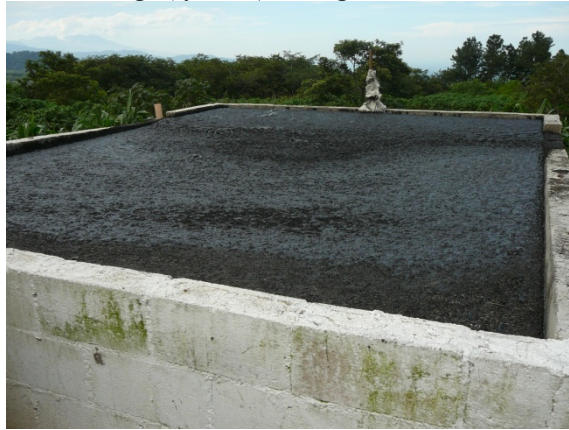
Figura 23: Tanque de descarga (efluente) del digestor anaerobio de la Granja La Flor.
