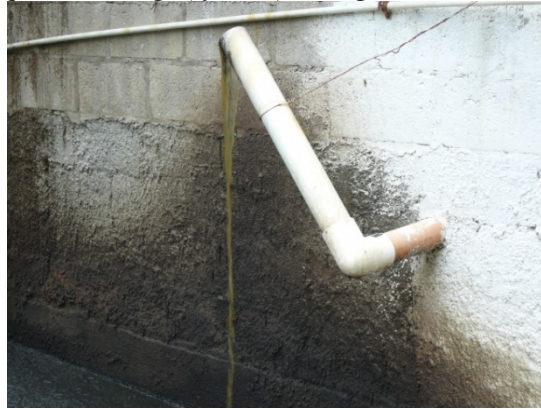
Figura 32: Rebalse del tanque de descarga (efluente) del digestor anaerobio de la Granja Agua Blanca.
