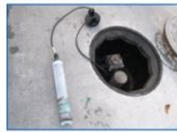
Detector de fuga para intersticio con agua salobre
