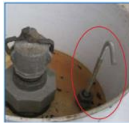
Figura 11. Válvula de drenaje
