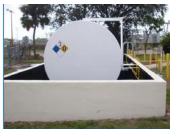
Verifique cobertura del tanque e integridad del contenedor
