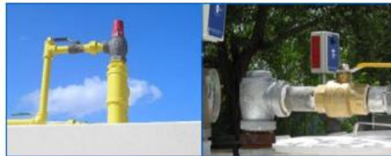
Válvula anti-sifón con válvula de aislamiento
