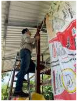
Colocación de cortinas.
