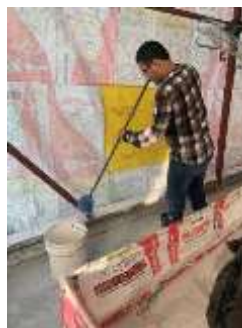
Desinfección con Cal.
