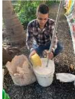
Aplicación de Cal.
