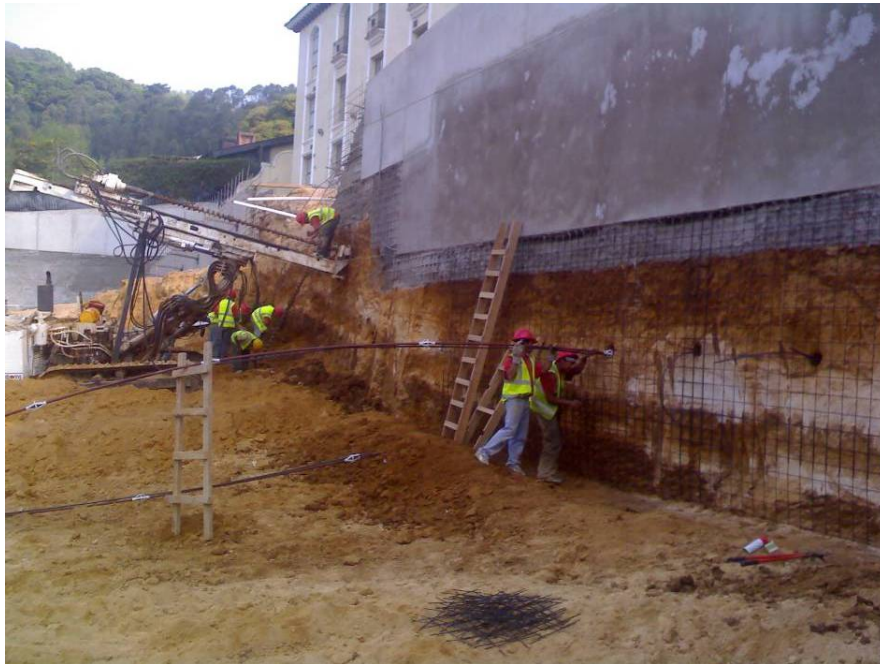
Figura VII-4 Colocación de pernos de anclaje.
