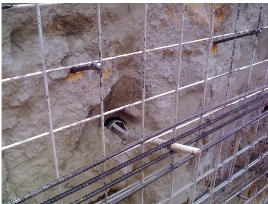
Figura VII-6 Colocación de pernos e inyección de anclaje.
