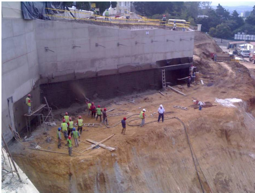
Figura VII-10 Lanzado de concreto.
