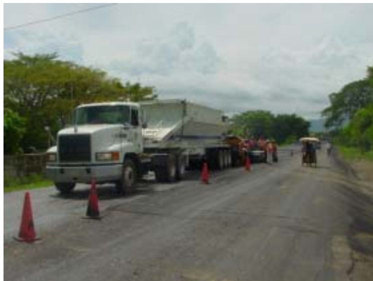
FIGURA 8: Equipo utilizado para el acarreo de concreto asfáltico ( Flow Boys).
