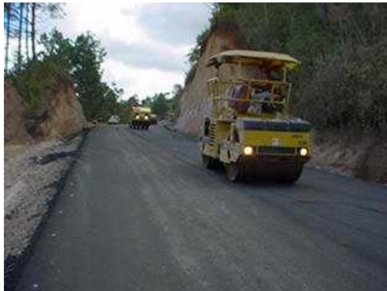
FIGURA 11: Equipo para compactar la carpeta asfáltica.
