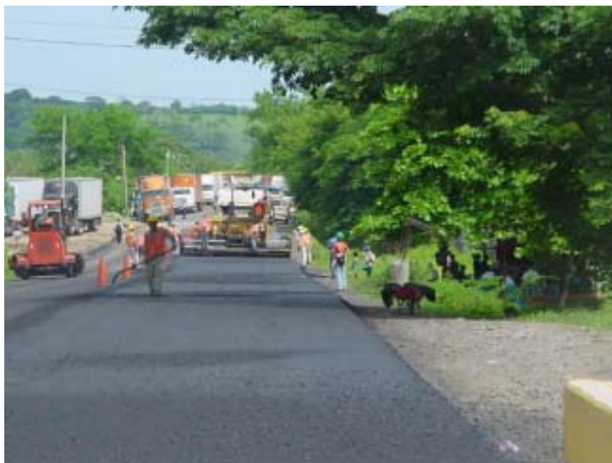
FIGURA 12: Proceso de colocación de carpeta asfáltica.
