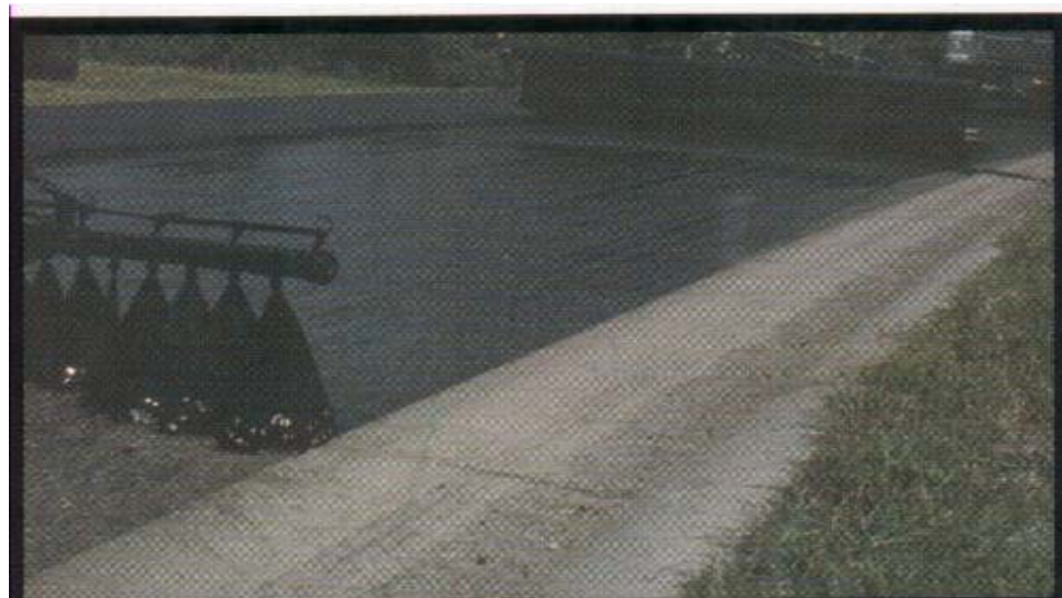
FIGURA 9: Riego de liga por medio de una distribuidora de asfalto.
