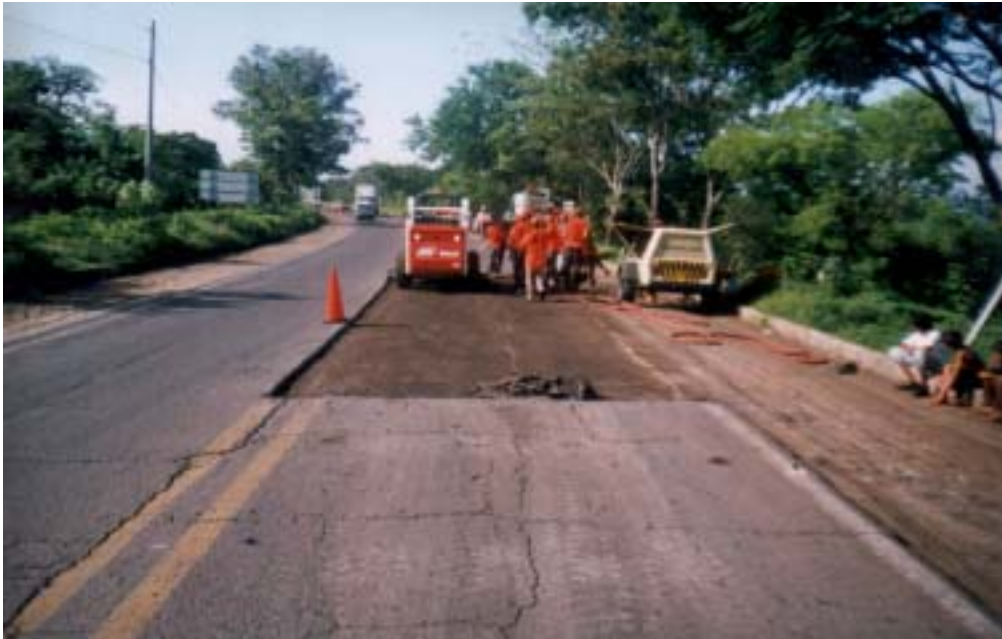
FIGURA 20: Limpieza del bache.
