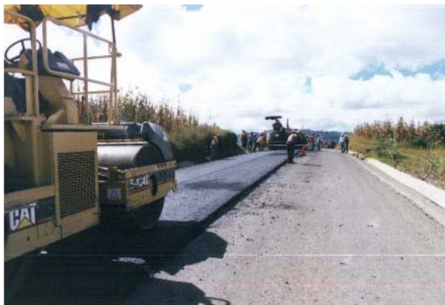
FIGURA 13: Proceso de compactación de la carpeta asfáltica.
