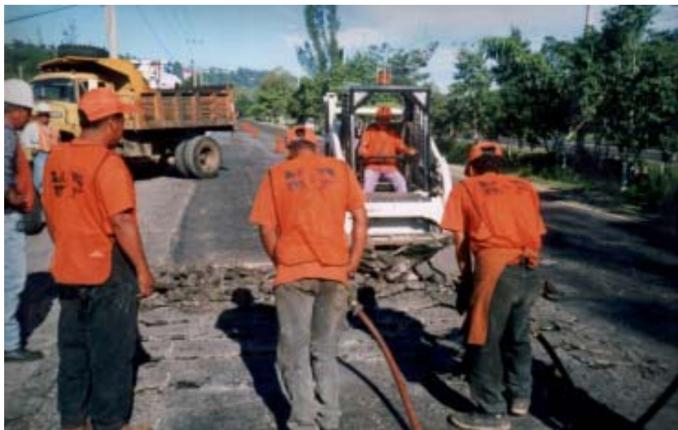
FIGURA 19: Corte del bache.
