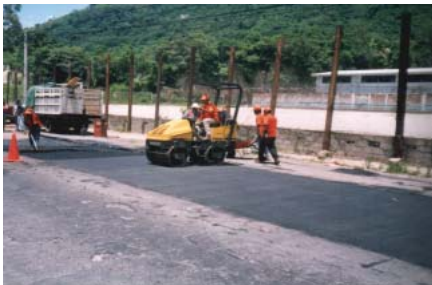
FIGURA 21: Compactación del bache.
