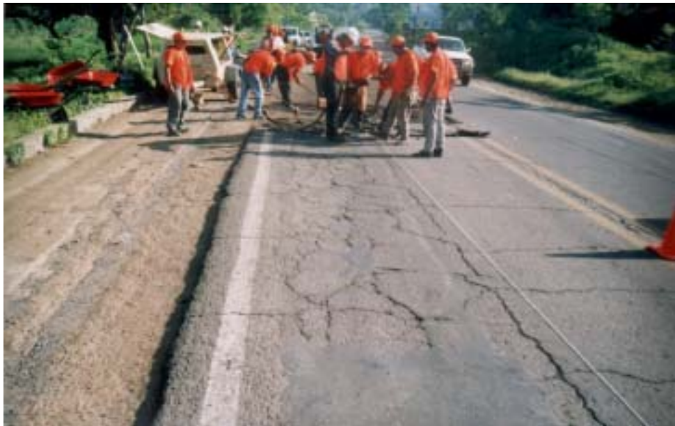
FIGURA 19: Corte del bache.
