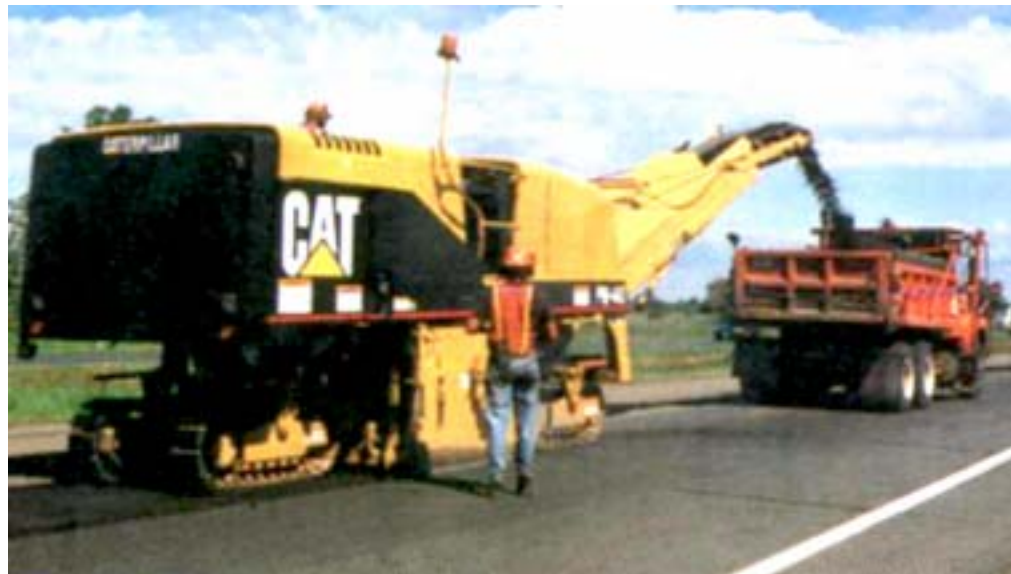
FIGURA 6: Carga de camiones con material producto del fresado.
