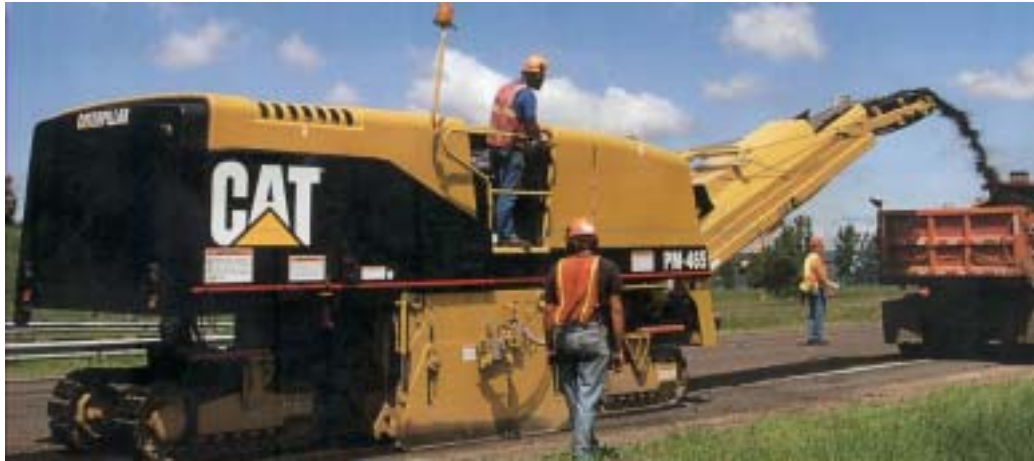
FIGURA 5: Fresado de la carpeta existente con una recuperadora CAT PM-465.
