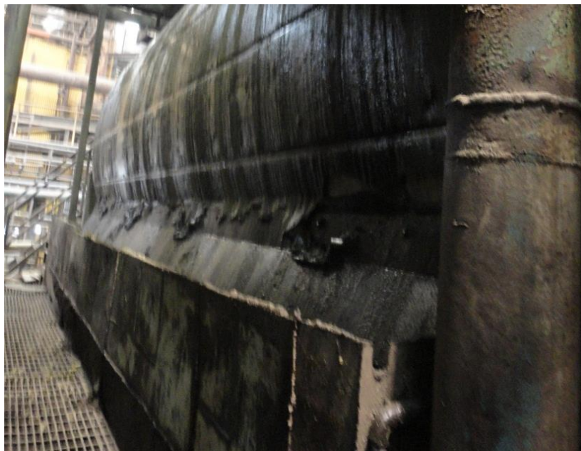
Ilustración No. 94 – Aspa para desprender la torta de lodo seca.
