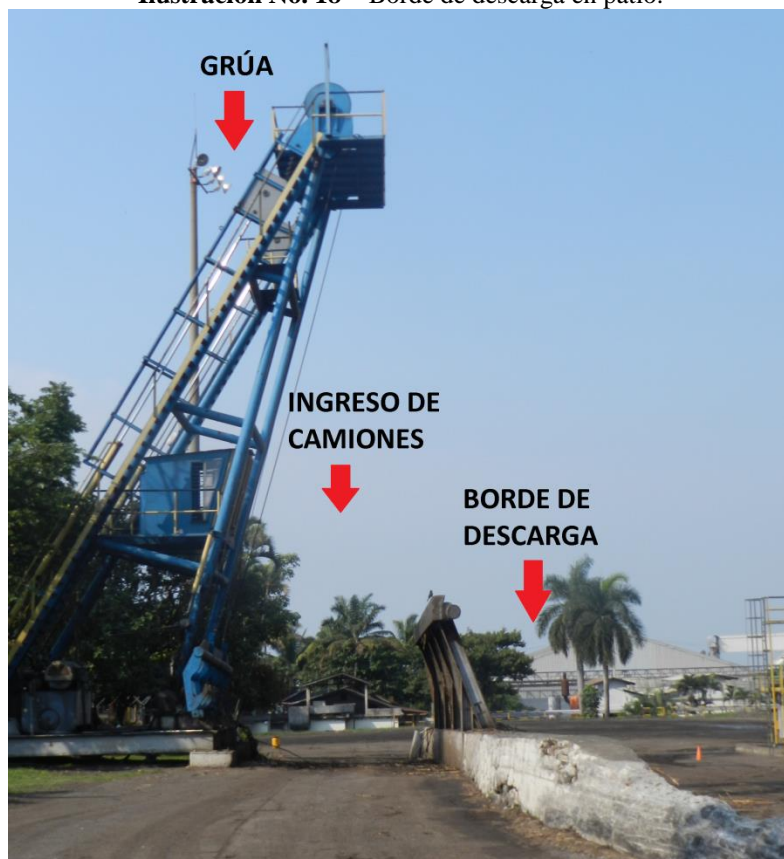
Ilustración No. 18 – Borde de descarga en patio.
