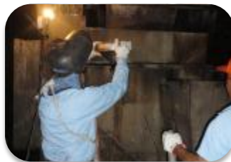
2. Instalación del embudo.
