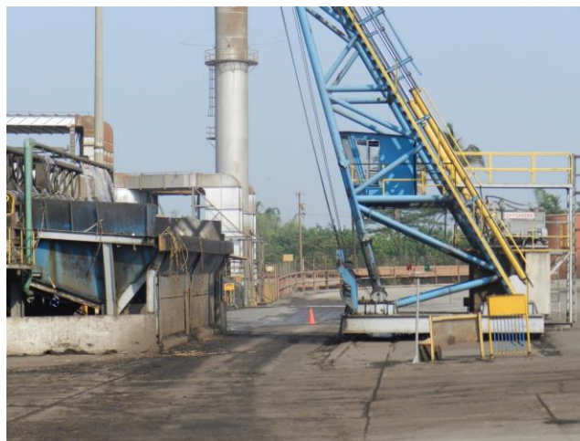
Ilustración No. 23 – Mesas de descarga de caña.
