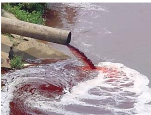
Ilustración 94. Sistema alcantarillado agrícola
