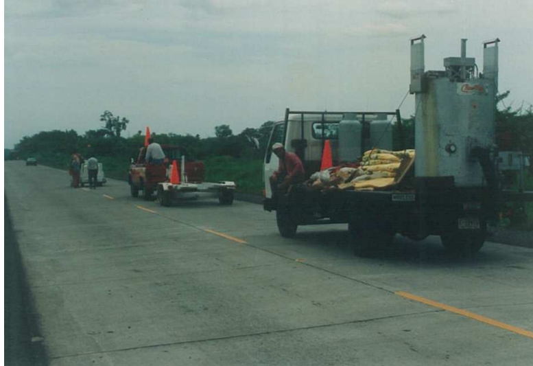
EQUIPO DE SEÑALIZACIÓN EN EL PROYECTO ESCUINTLA – PUERTO QUETZAL
