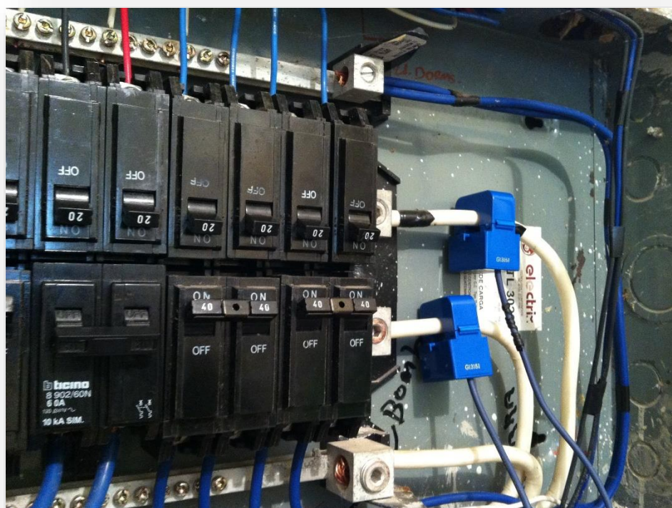
Figura No. 30: Sensores Instalados 2.
