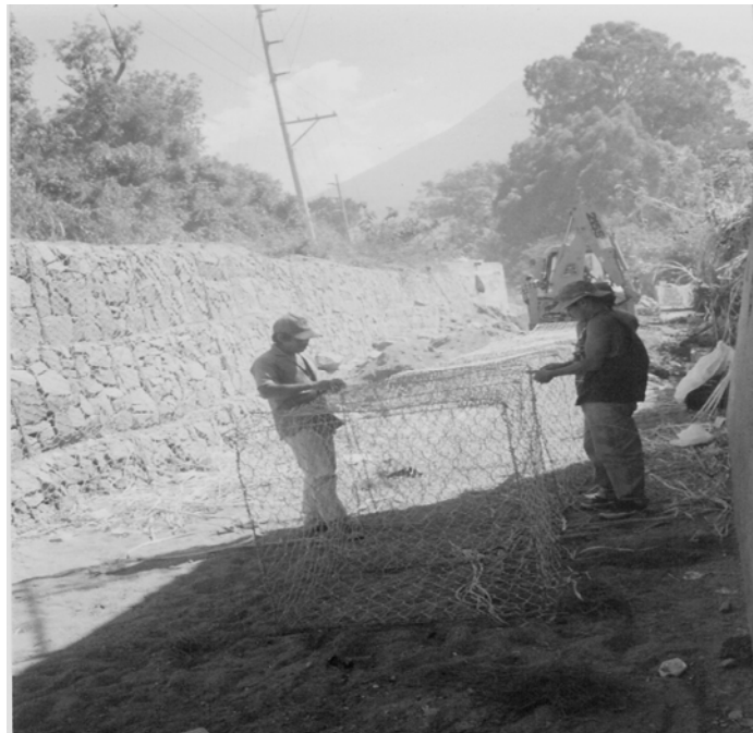
FIGURA 8. Armado de canasta en campo
