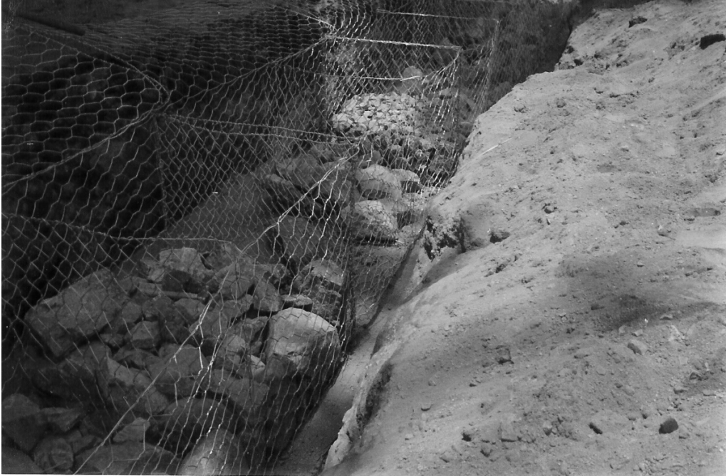
FIGURA 9. Llenado de canastas con piedra
