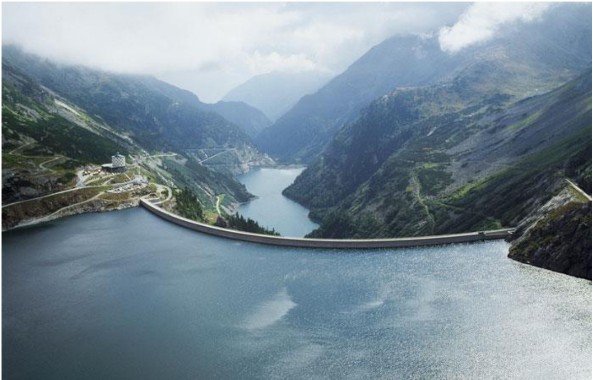
Figura No. 6 Central de bombeo convencional
