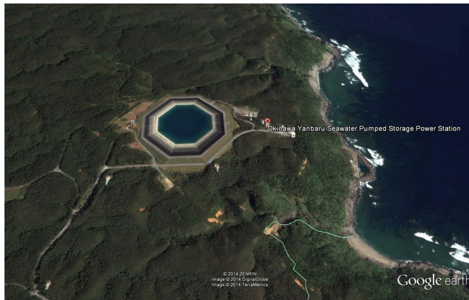
Figura No. 8 Central de bombeo de agua de mar
