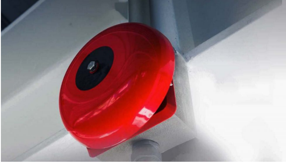
Figura 9: Alarma sonora contra incendios [5]
