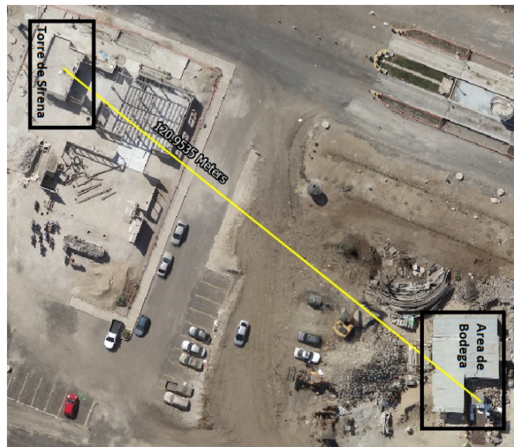
Figura 19: Distancia de prueba de sirena a bodega.
