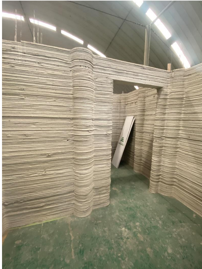
Figura 20. Vista de interior de primer proyecto de vivienda hecho por Cementos Progreso
