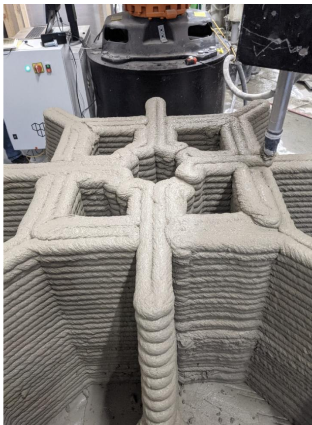
Figura 9. Foto realista del proceso de impresión de pedestal
