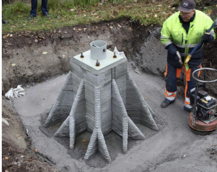
Figura 10. Pedestal impreso ya instalado en fundición
