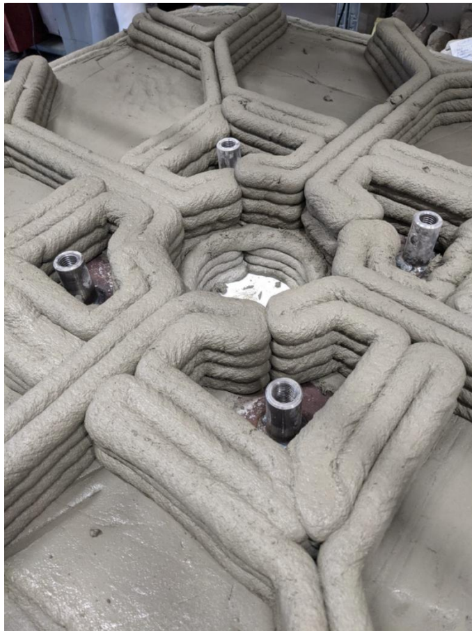
Figura 11. Armadura interna de pedestal impreso en 3D
