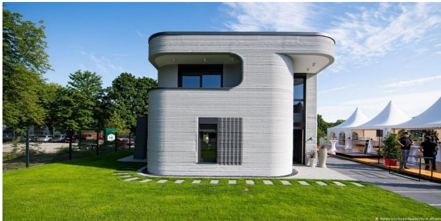
Figura 3. Vivienda construida con tecnología de impresión 3D de concreto
