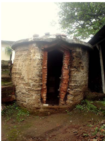
Figura No. 34: Horno para la cochura de la mayólica
