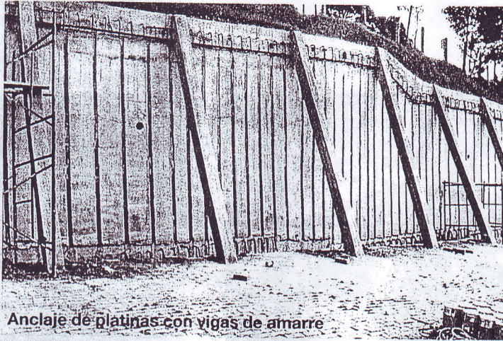
Colocación platinas
