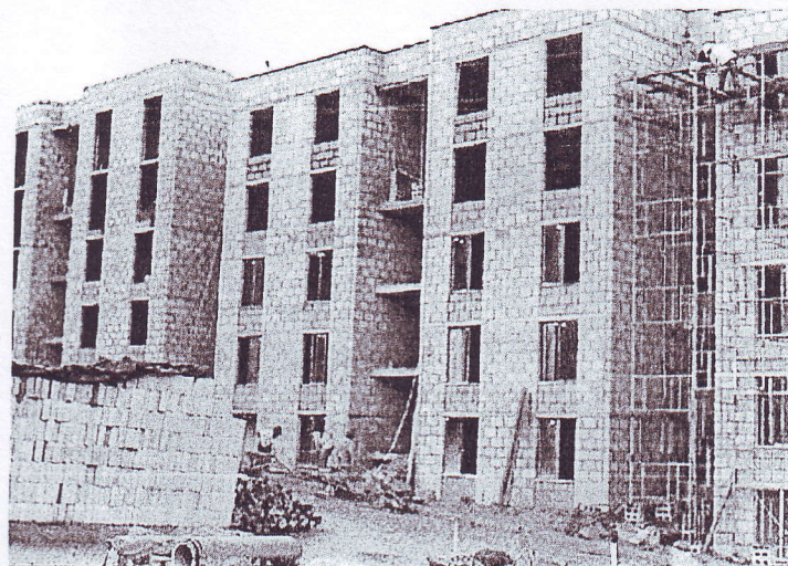
Figura 4: Edificio multifamiliar en mampostería reforzada.
