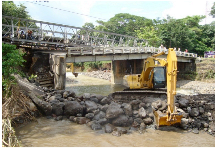
Figura 35: Puente Bailey instalado sobre estructura original,
