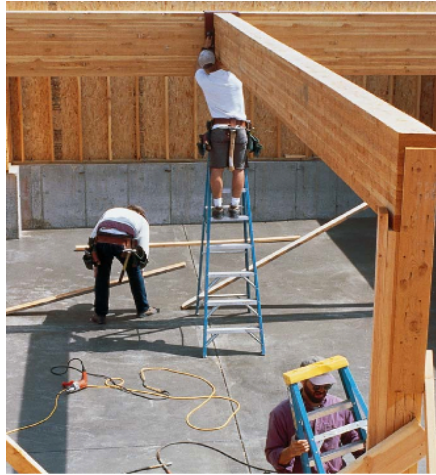
Figura 14: Ejemplificación de la fácil instalación de viga laminada
