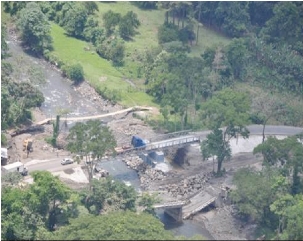
Figura 38: Vista panorámica Puente San Francisco,
