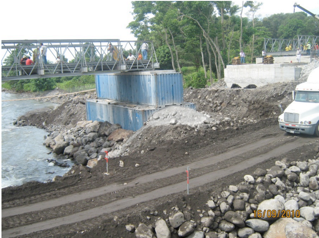
Figura 37: Paso Bailey con apoyo intermedio,
