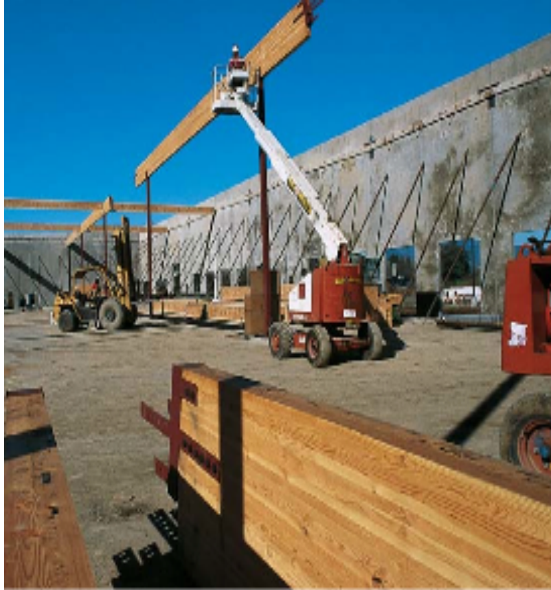
Figura 11: Instalación de una viga de 38 pies
