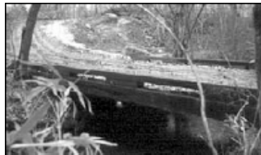
Figura 97: Puente de Emergencia de Paneles Glulam
