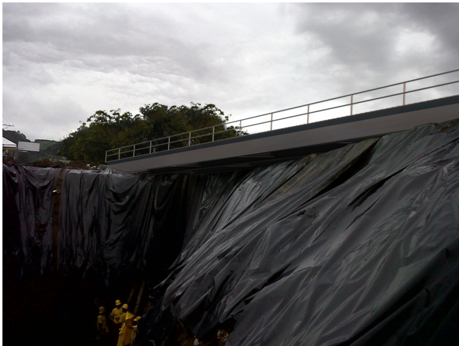
Figura 112: Montaje de estructura diseñada en hundimiento de Km14 Carretera al Pacifico
