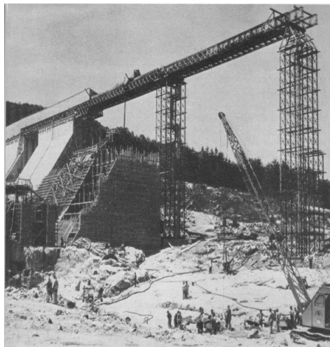
Figura 60: Puente Bailey soportado por torres fabricadas de puentes Baile
