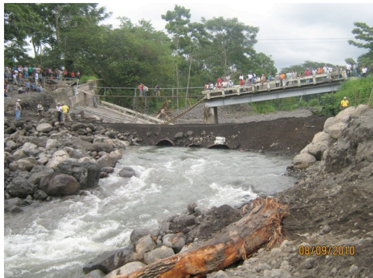
Figura 36: Puente colapsado,
