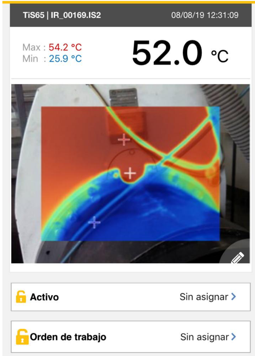
Figura 25. Temperatura a la que trabaja el motor de la extrusora Starex 8
