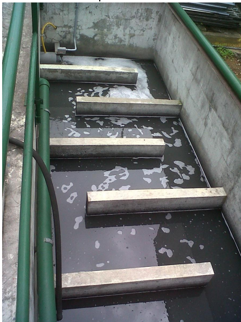
Imagen 10 Tanque de decantado
