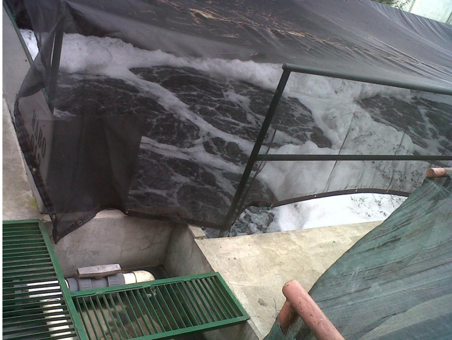
Imagen 6 Tanque de aireación No. 2
