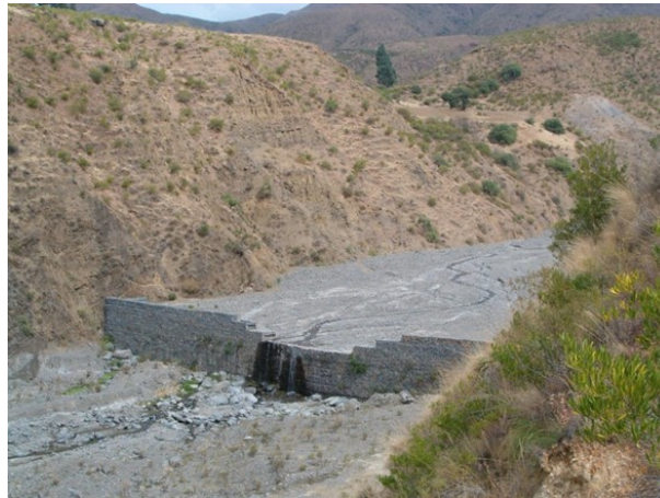
Figura 27: “Reservorio dique - represa con gaviones”
