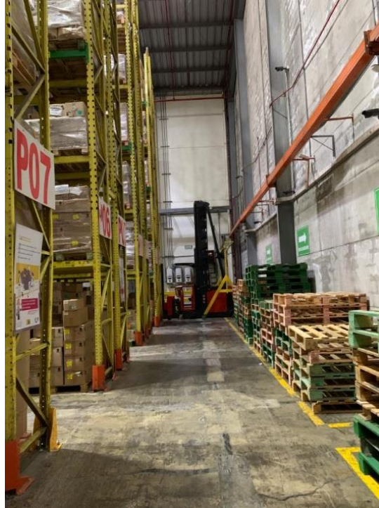
Figura 25. Espacio físico para Rack Picking
